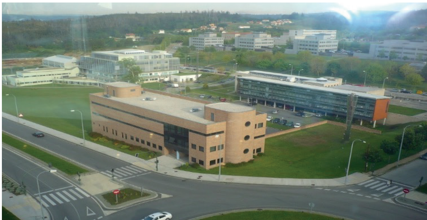
► Edificio do Instituto de Cerámica de Galicia, no Campus Sur da USC.
